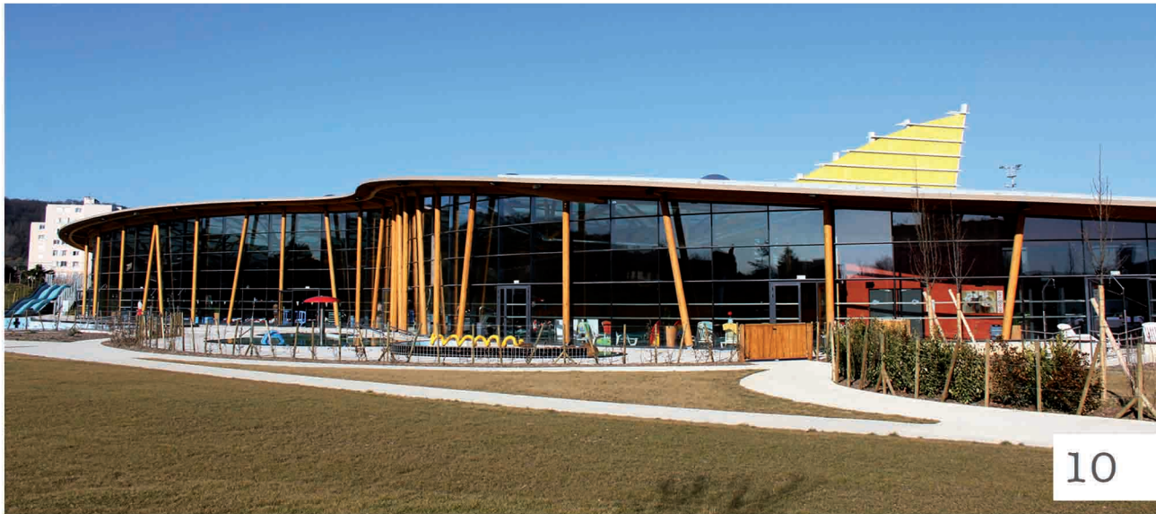
Voile décorative, ossature poteaux et lisses en tube Remplissage en tôle perforée
