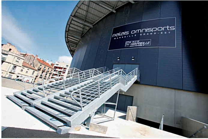
Escalier de secours métallique galvanisé
